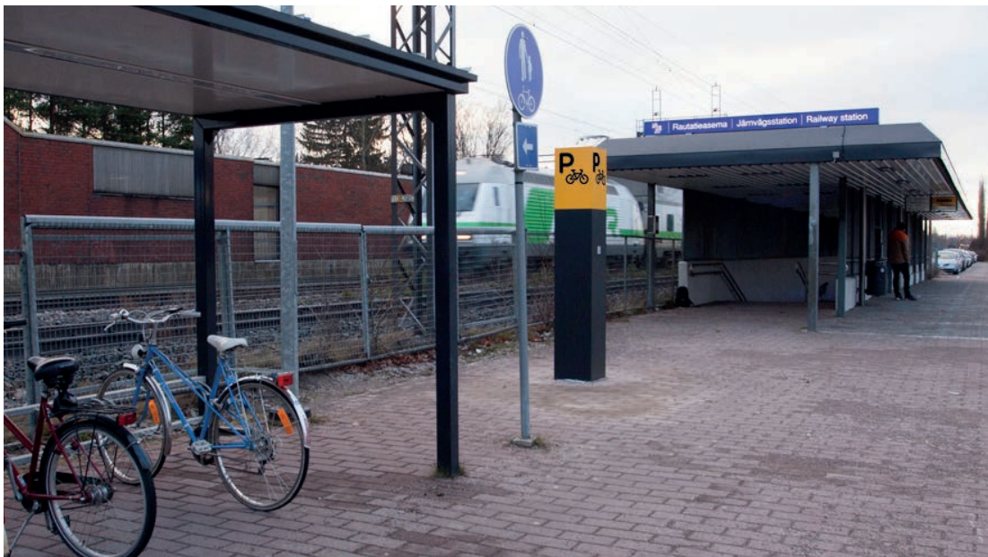
Kuva 4. Pyloni Puistolan asemalla
