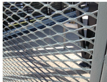
Ero rakenteen pinnan ja verkon välillä on 7mm.
