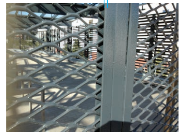
Ero rakenteen pinnan ja verkon välillä on 7mm.
