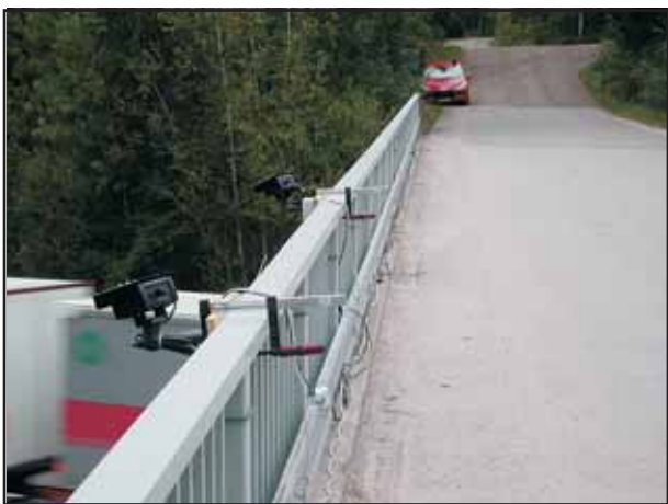
Kamerat kiinnitettyinä sillan kaiteeseen
