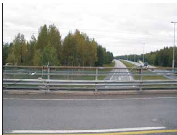
Kamerat kiinnitettyinä sillan kaiteeseen
