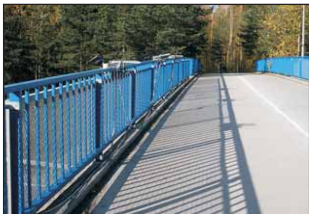
Kamerat kiinnitettyinä sillan kaiteeseen
