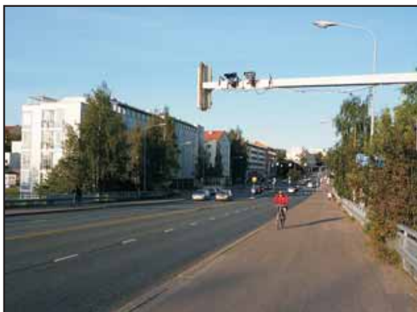
Kamerat kiinnitettyinä porttaaliin
