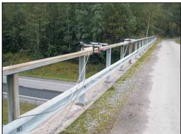
Kamerat kiinnitettyinä sillan kaiteeseen
