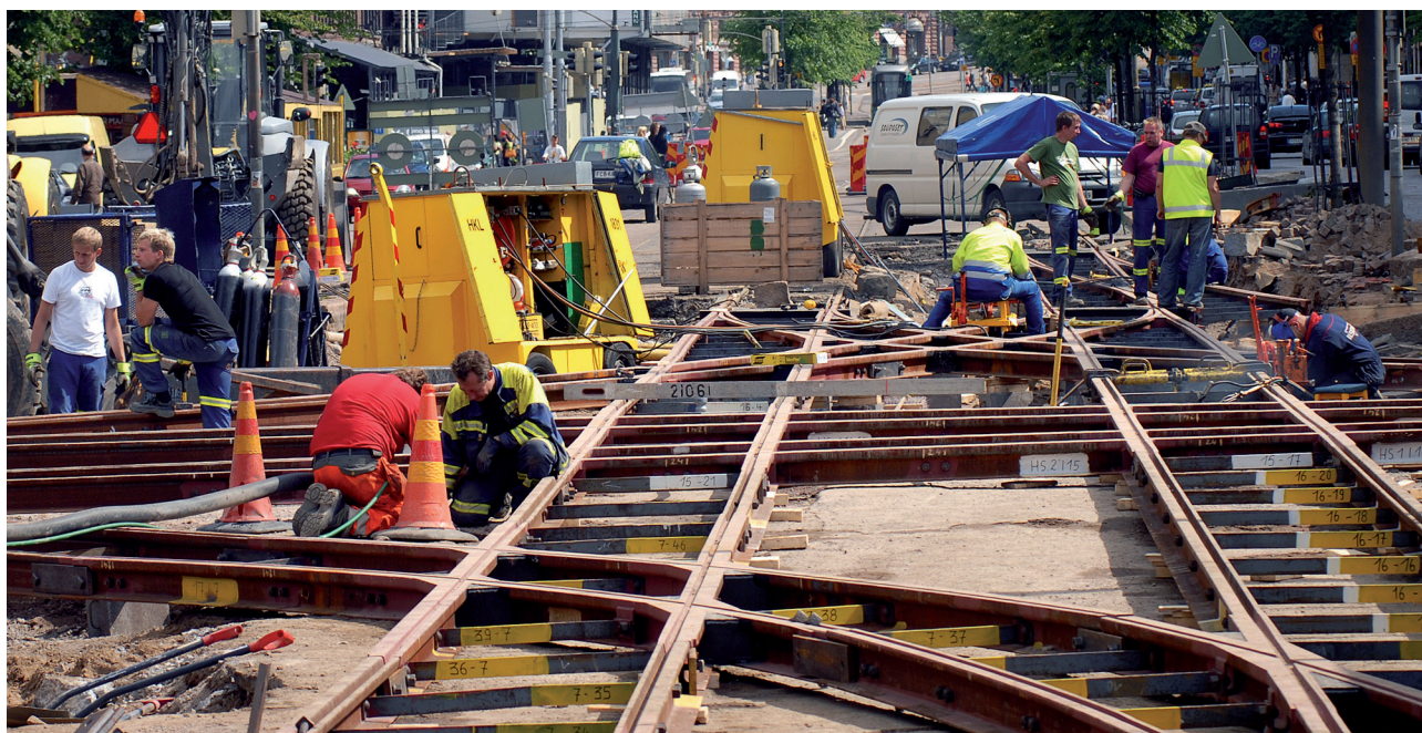
Kuva 17. Kamppiin ja linjalle 9 rakennettiin uutta raitiorataa kaikkiaan 6,8 kilometriä vuosina 2007 ja 2008. Kuvassa Mannerheimintien ja Kaivokadun risteysurakka.
