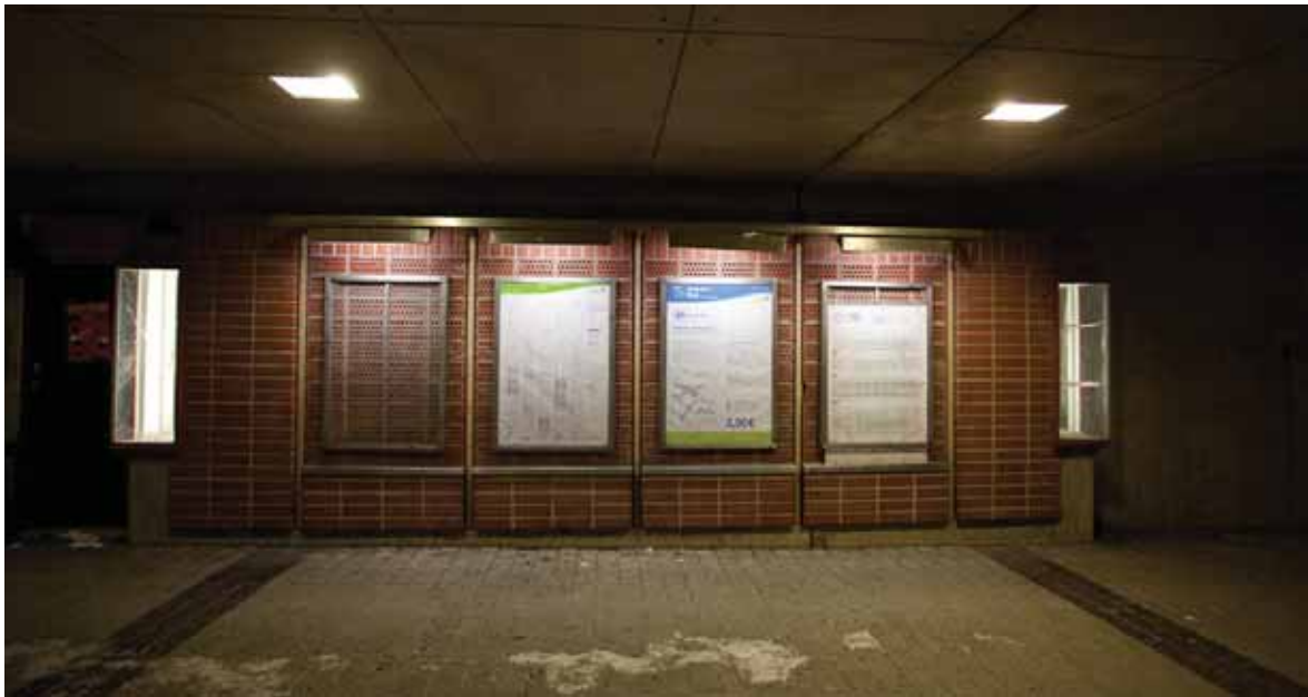
Kuva 6.4-6 Erilliset opastevalot valaisevat opasteet tehokkaasti ja ylhäältä tuleva valo ei aiheuta heijastuksia.
