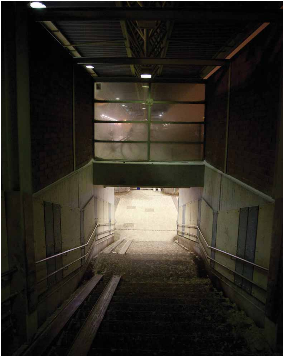
Kuva 9.3-2 Huoltorajojen epäselvyyksien ja hankalan huollon takia portaiden valaisimet jäävät helposti huoltamatta.
