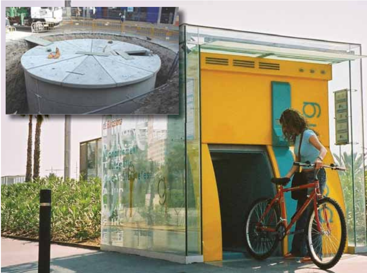
Kuvat 6.3-6 ja 6.3-7 Automaattiset pyöränsäilytysjärjestelmät suojaavat pyörää, vasemmalla rakenteilla oleva laitos, oikealla maanpäällä näkyvä osa (Espanja).
