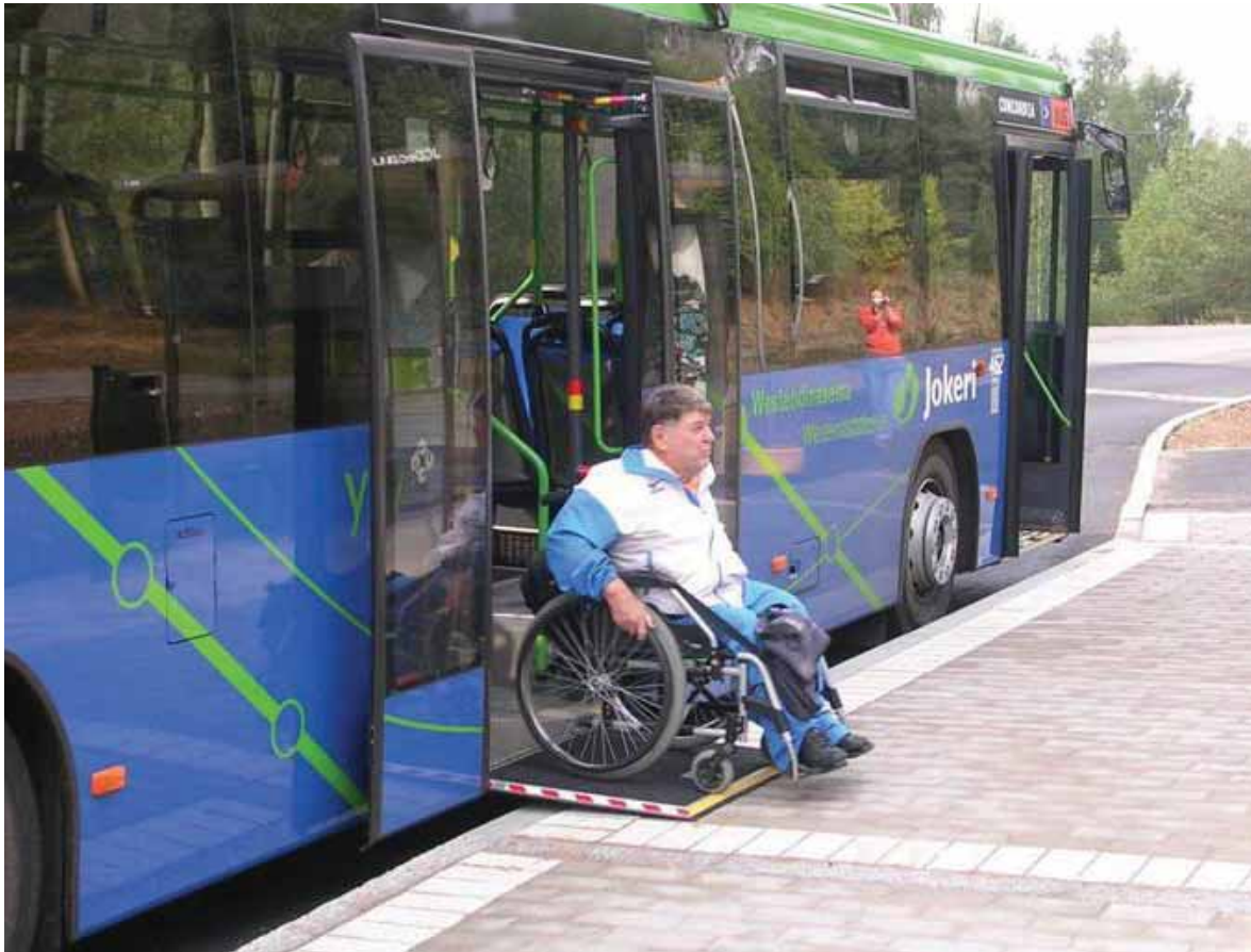
Kuva 8.1-2 Espoon Puolarmetsän sairaalan kohdalle Puolarintielle rakennetun bussipysäkin reunatuki on rakennettu osin 20 cm korkeana. Korotus on kahdelle bussille mitoitettun pysäkkisyyvennyksen etupäässä, jolloin bussilla on saapuessaan riittävästi tilaa oikaista ajoneuvo reunatuen suuntaiseksi.
