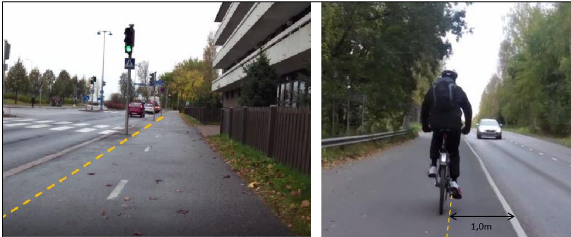
Kuva 12 Pyöräväylän leveys määritellään väylää rajaavien elementtien väliseksi etäisyydeksi. Pyörätiellä tulee (tietty yksisuuntaiset järjestelyt pois lukien) olla vähintään metrin levyinen erotuskaista ajoradan suuntaan.
