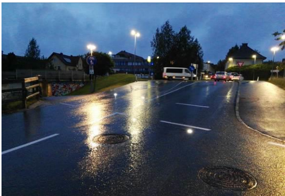
Kuvat 4. Led-valot tien ylityksessä Lamprechtshausenissa Itävallassa. (kuva: Gifas)
