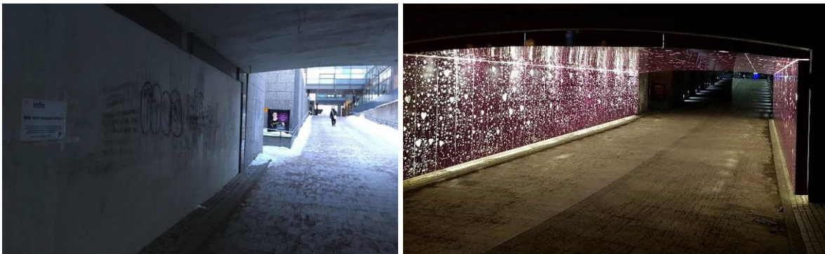
Kuva 9. Vasemmalla Alberganportin alikulkutunneli Espoon Leppävaarassa ennen ja oikealla jälkeen Love, Love (Tunnel of Love) -valotaideteoksen toteutuksen (kuvat: Mette Granberg), katso myös Liite 1: toimenpidekortit, kortti 6 Alikulkujen viihtyisyyden parantaminen.
