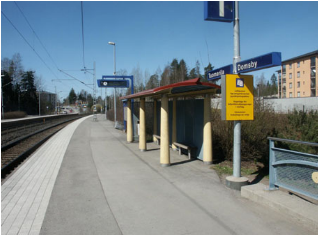
Kuva 20. Tuomarilan asemalla katokset ovat mitoiltaan vaatimattomia, mutta niiden ulkoisessa olemuksessa on haettu persoonallista ilmettä. Asuinrakennukset ja asemaa sivuava katu ovat näköetäisyydellä.
