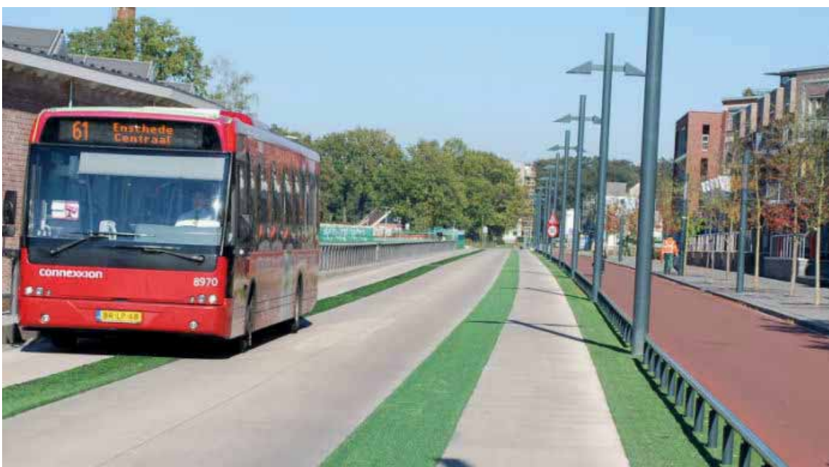
Kuva 36. Eroteltu bussikaista Twentessä ( www.bhls.eu ).
