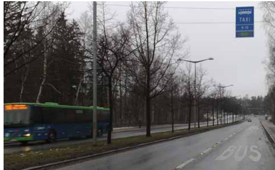
Kuva 31. Esimerkki kuinka bussikaistan näkyvyyttä voidaan tehostaa kaikkein vaativimmissa tilanteissa, jolloin kaistaviivojen väleihin on lisätty LED-valaisimet ja bussikaistan voimassaoloaikaa on selvennetty vihreällä LED-näytöllä.
