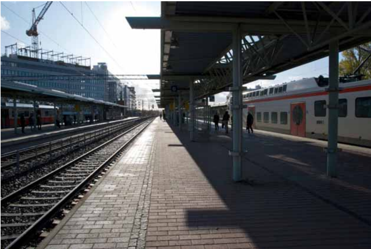
Kuva 24. Näkymä laitureilta 2 ja 3 etelään. Pysähdyksissä oleva juna peittää näkymää asemarakennukselle ja porraskuilun sijainti on hankala erottaa laiturin rakenteiden vuoksi. Vastavalo iltapäivällä korostaa ongelmia.
